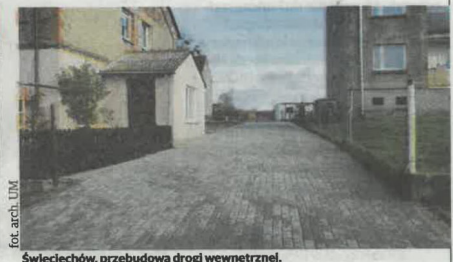
Święciechów, przebudowa drogi wewnętrznej.
