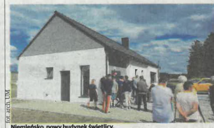
Niemieńsko, nowy budynek świetlicy.
