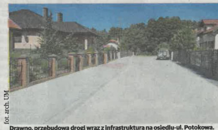
Drawno, przebudowa drogi wraz z infrastrukturą na osiedlu-ul. Potokowa.
